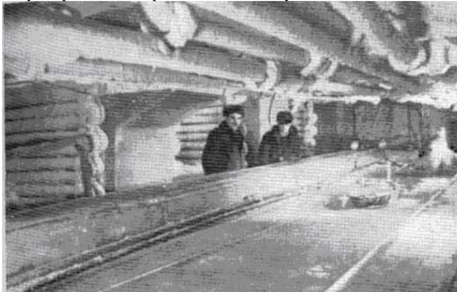
Рисунок 5. Общий вид ледового опытового бассейна
